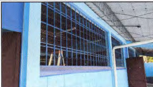
FOTO 7: Mantenimiento a balcones de metal. En aula
