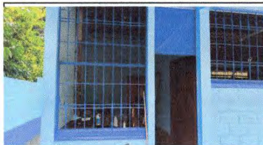
FOTO 11: Mantenimiento a balcones de metal En modulo de cocina
