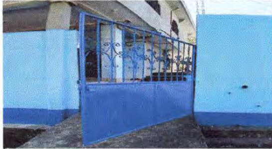
FOTO 14: Mantenimiento a portones de metal. En entrada principal del establecimiento.
