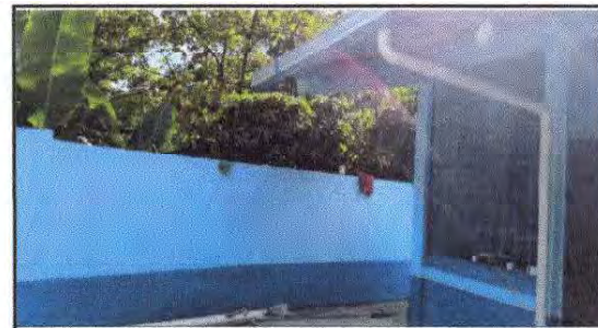
FOTO 6: Sustitución de bajada de agua pluvial de metal por tubo PVC 3" modulo de patio
