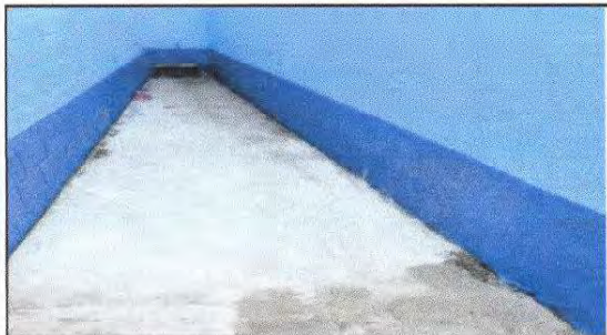
FOTO 3: Sustitución de tubería línea principal. En baños.
