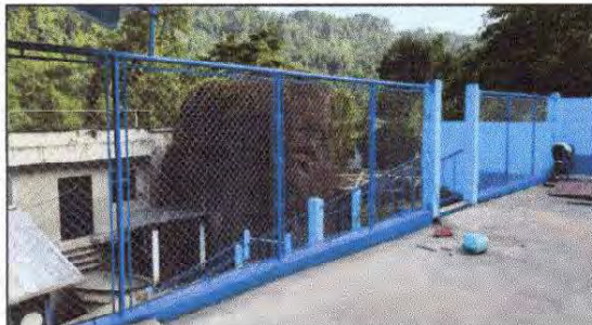
FOTO 15: Reparación de tubo hg y malla galvanizada. En patio
