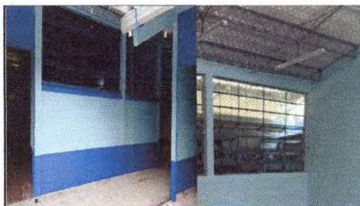
FOTO 9: Pintura en muros exteriores e interiores en modulo de aulas
