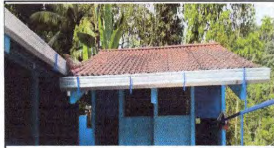
FOTO 2: Sustitución de canal de metal incluye soporte de metal. En baños
