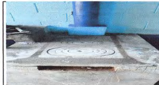
FOTO 12: Sustitución de plancha de metal de 3 hornillas Y Sustitución de chimeneas de concreto por tubo de metal en modulo de cocina
