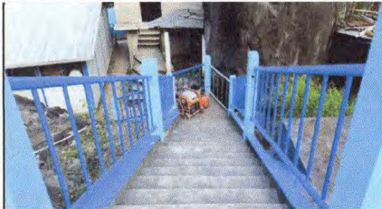
FOTO 13: Sustitución de barandas de metal. Por tubo hg galvanizado. En patio
